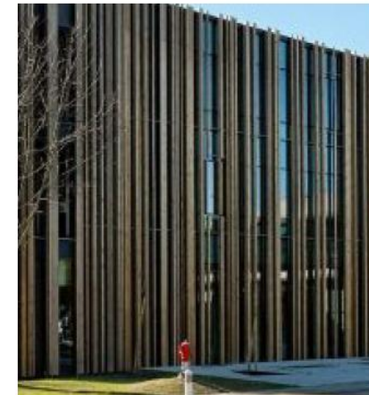
Institutsgebäude in Gragnan, Patrick Arotcharen
