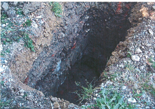
Abb. 2: Aufschluss (Bagger Schlitz)
